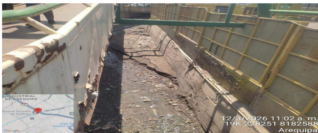
FIGURA N°01: TRAMO CRÍTICO EN LA QUEBRADA LOS INCAS, PARA DESCOLMATACION DE CAUCE.
