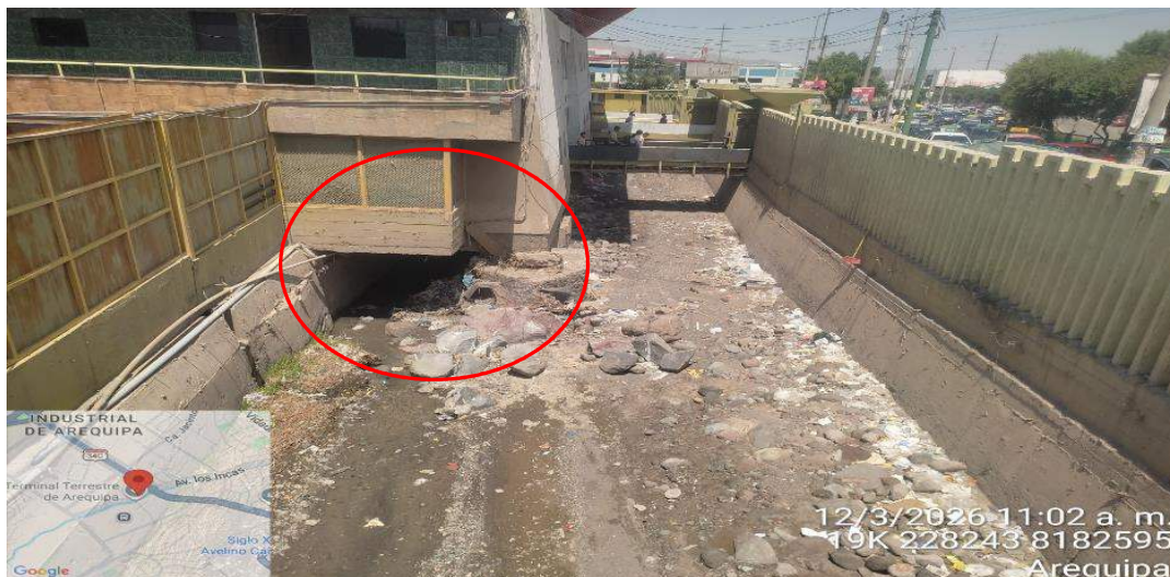
FIGURA N°02: TRAMO CRÍTICO SE MUESTRA LA COLMATACION Y EL DESVIO DE LA QUEBRADA POR DEBAJO DEL TERMINAL TERRESTRE
